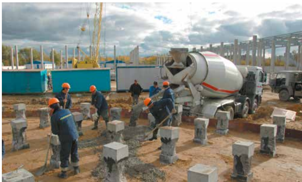
Этапы строительства Юго-Западной ТЭЦ. Архив
