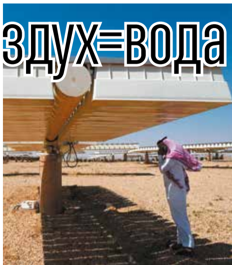
Солнечная электростанция в Уайне к северу от Эр-Рияда.
