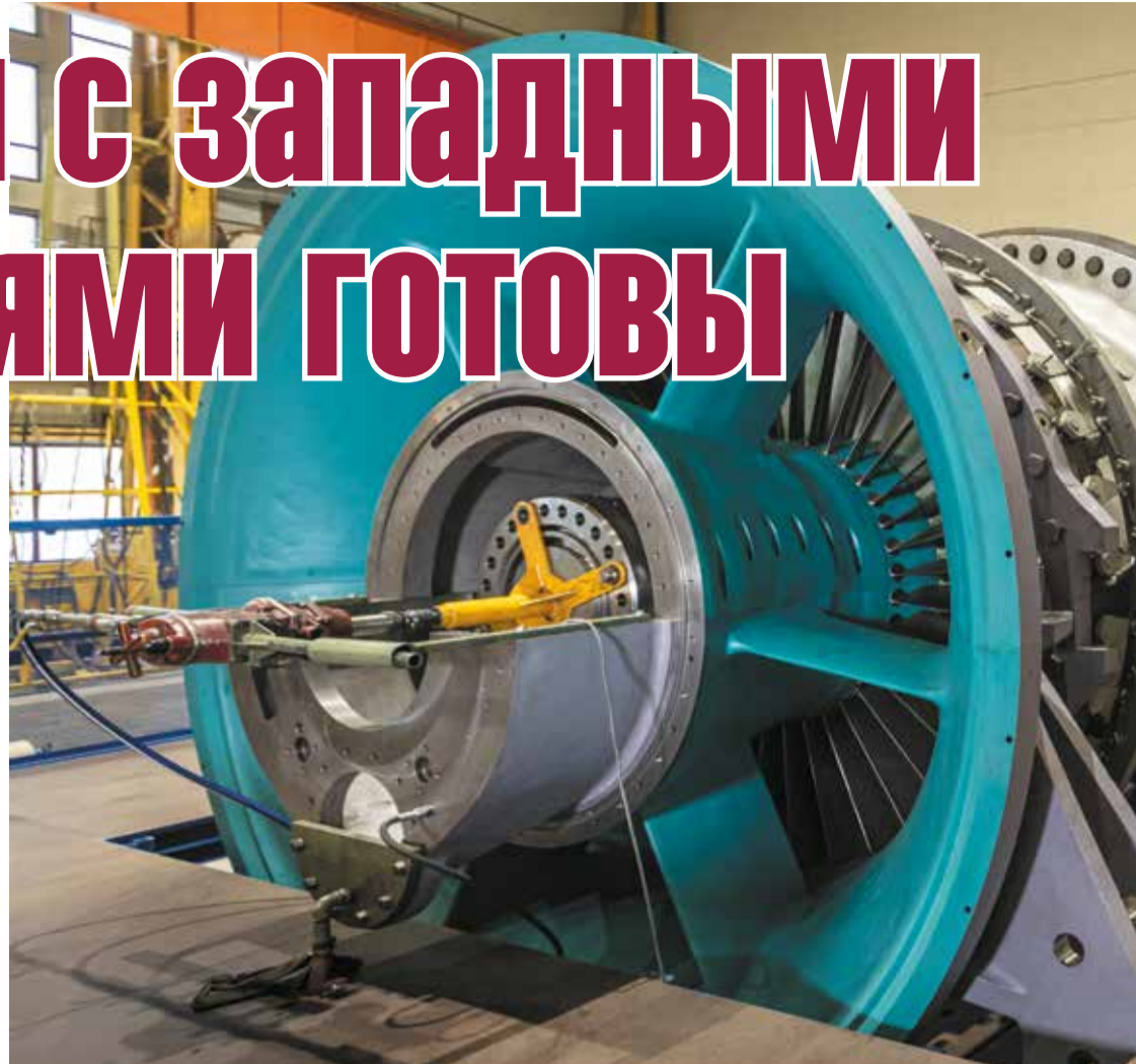
Начало монтажа ГТЭ-170 на стройплощадке Киришской ГРЭС: турбина устанавливается в проектное положение Фото «Интер РАО — Инжиниринг»
