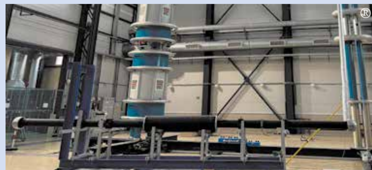
Высоковольтные испытания ТПЛ с RIP-изоляцией на 110 кВ
